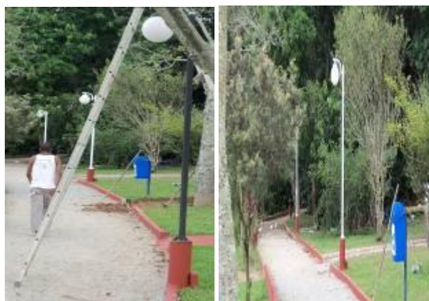
Pintura dos postes de iluminação na chácara
