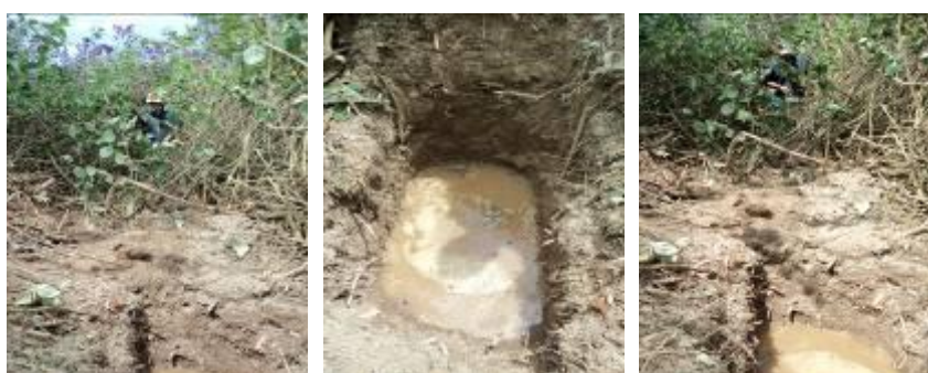
Desobstrução da vala
