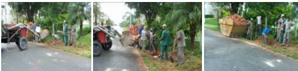
Retirada de telhas doadas e entulho (apoio a morador)
