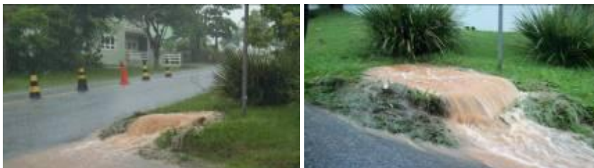
Situação de caixa de águas pluviais
