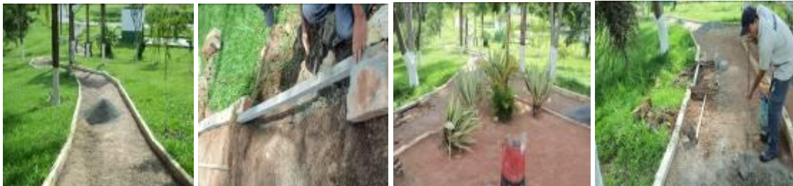
Manutenção pista Cooper do lago Cx03
