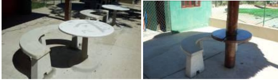
Colocação de bancos de concreto no clube
