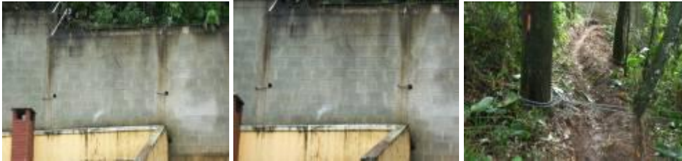
Contenção do muro e abertura de vala para desvio de água Q18
