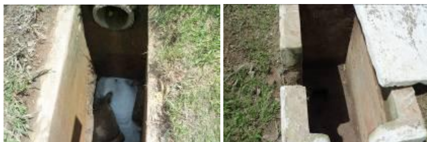
Limpeza da caixa
