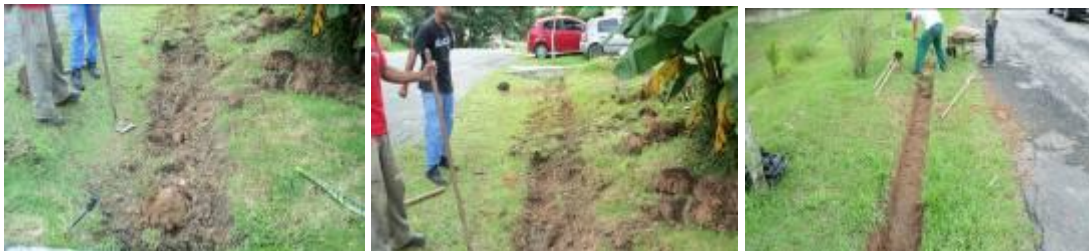
Abertura de vala da Q54
