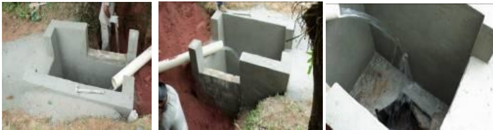
Reconstrução da Caixa hidráulica de águas pluviais Q 19
