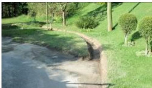
Abertura de vala final de rua Q 88
