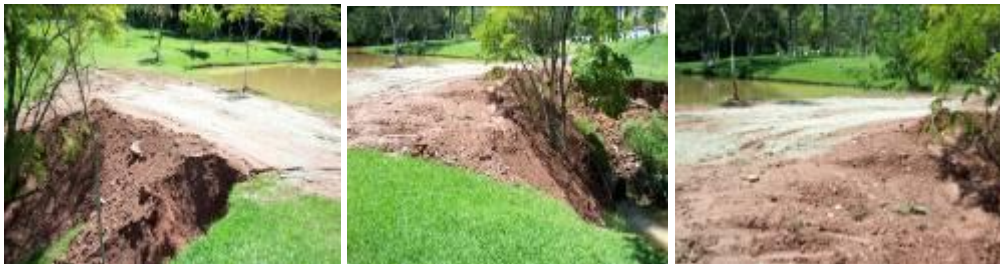
Reconstrução da barragem do lago devido erosão
