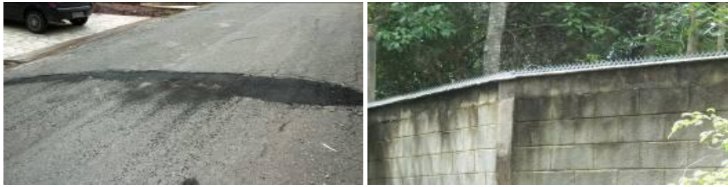
Tapa valeta Q 38 e colocação de lanças Q 10
