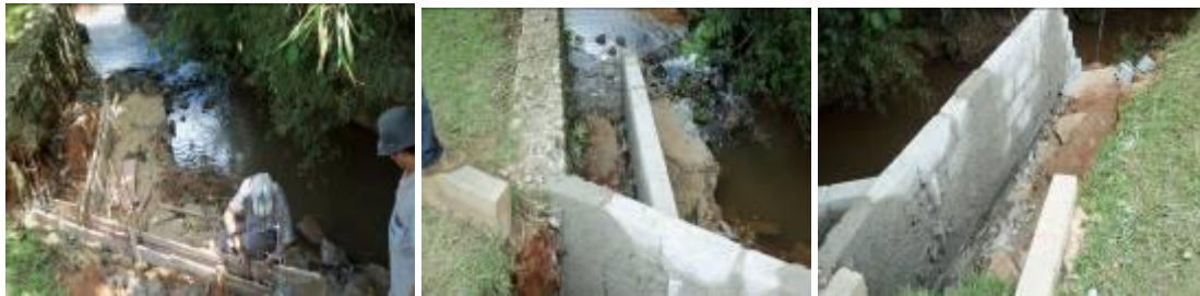
Construção de escada hidráulica no Lago 02 da chácara
