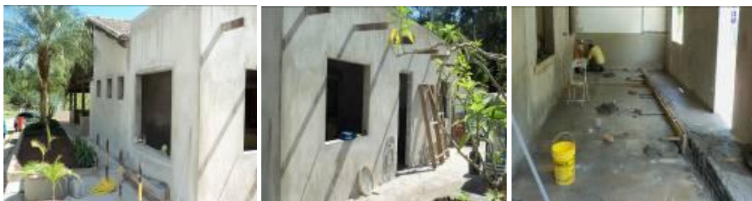
Reforma do restaurante da chácara
