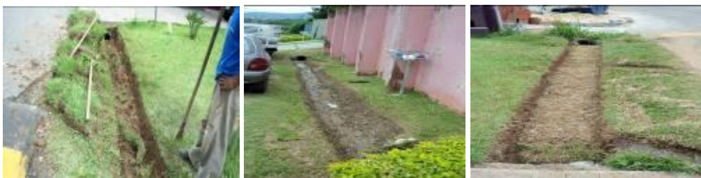
Abertura de valas por toda a rua da Q106 A/B
