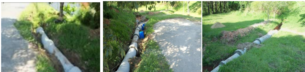
Colocação de tubos Q88 para área verde
