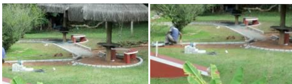
Construção de acesso aos quiosques e bebedouro na chácara
