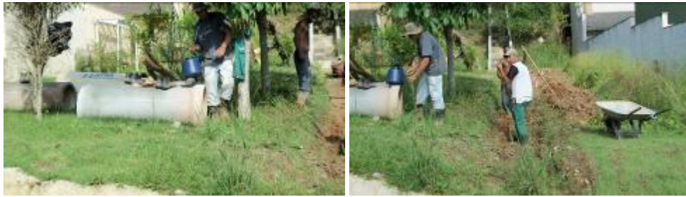
Preparação de tubulação Q18
