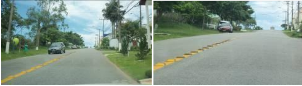
Colocação de tachão na subida do clube
