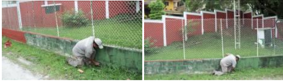
Pintura da entrada caixa poço 01
