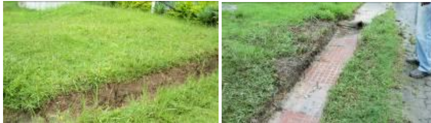
Limpeza e abertura de valas
