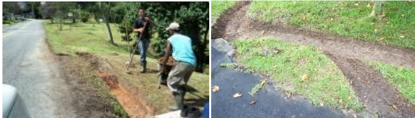
Limpeza e abertura de valas no lago
