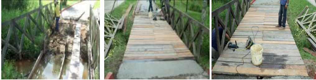
Manutenção da ponte da pista de Cooper
