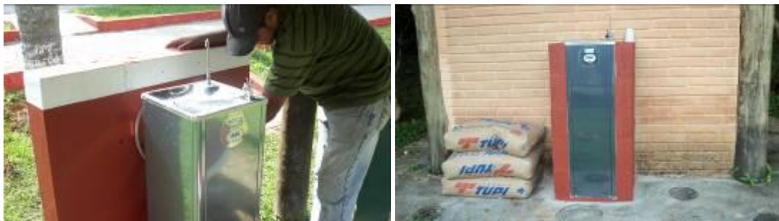
Instalação de bebedouros na chácara
