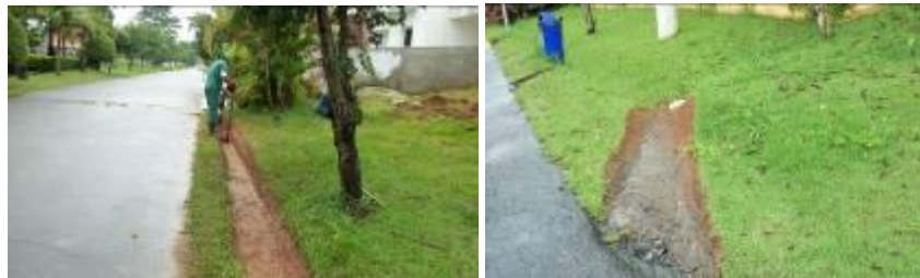
Limpeza e abertura de valas
