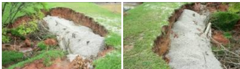
Colocação de areia para proteção dos tubos dos poços e posterior cobertura de terra
