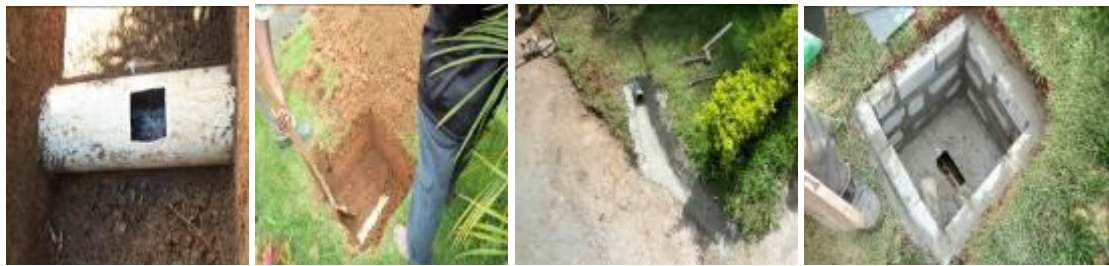
Construção de passagem de água pluvial e desobstrução Q 08
