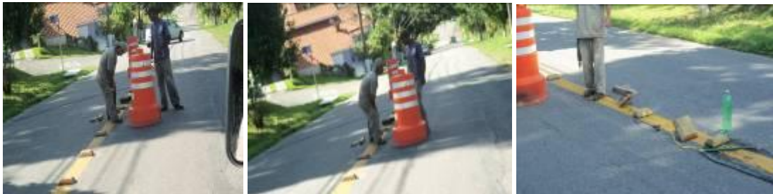
Colocação de mais tachão na subida do clube
