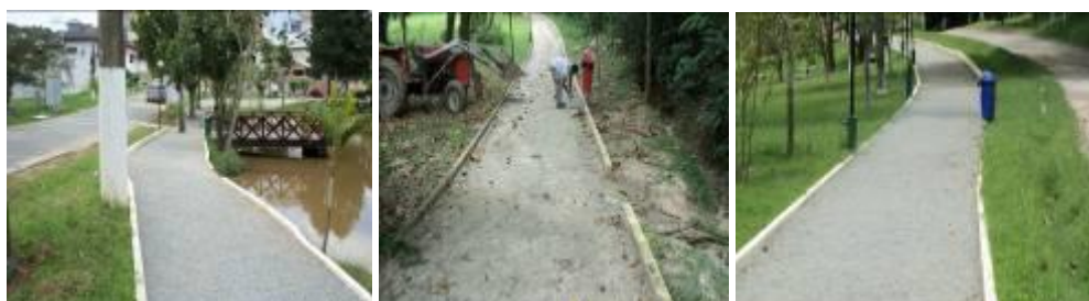
Colocação de pedrisco na pista de Cooper
