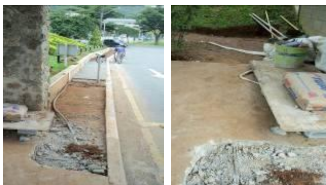
Pavimentação de calçada na P1
