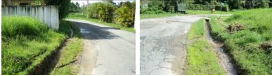
Abertura de vala Q56
