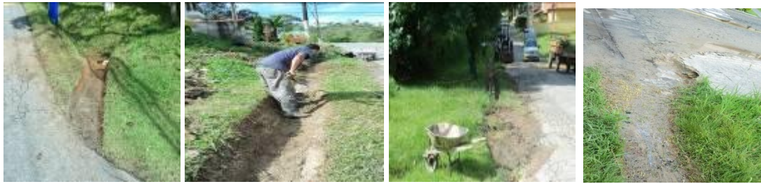
Corte, Limpeza e desobstrução das valas
