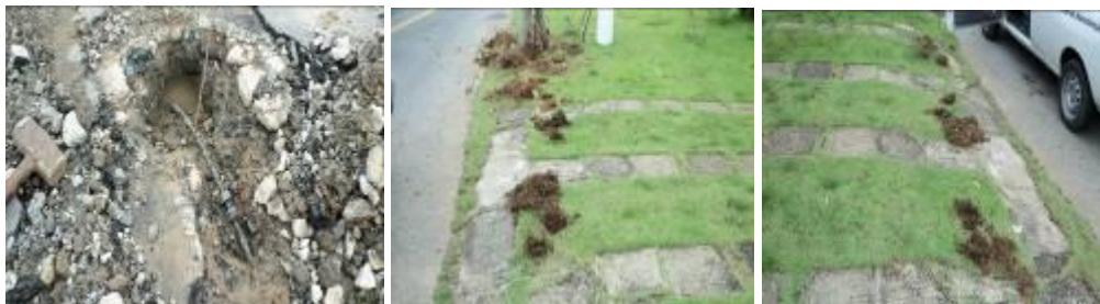
Eliminação de vazamentos Q 96
