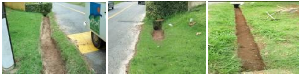
Abertura de canaletas Q 53 e Q 78
