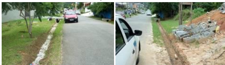
Abertura de valas por toda a rua da Q106 A/B
