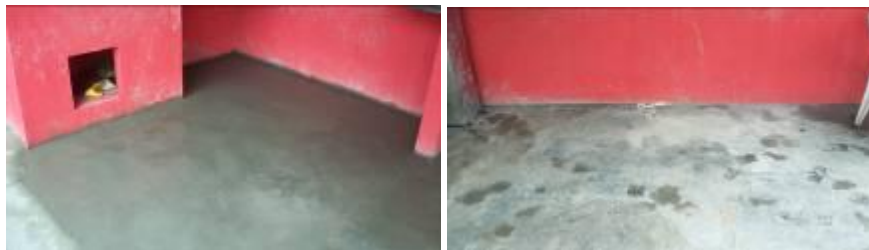
Realização de piso queimado no clube
