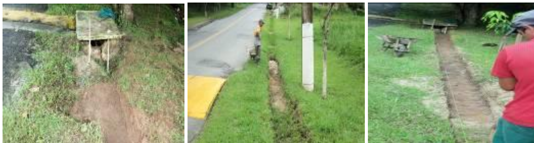
Abertura de canaleta Q 33
