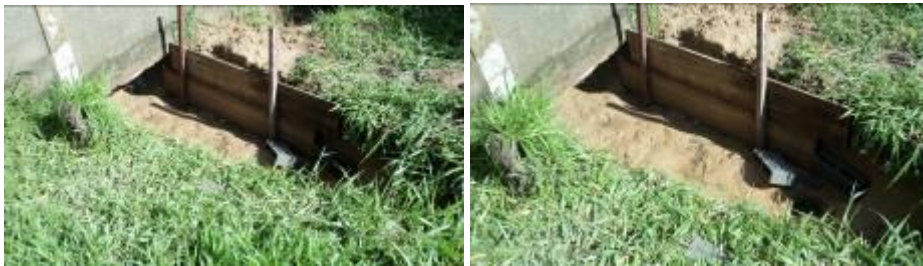
Desvio de águas pluviais Q44 com muro brisas
