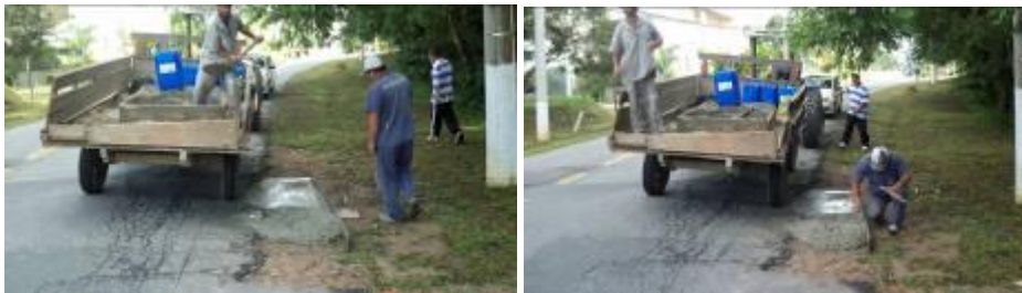
Concretagem da válvula Q32
