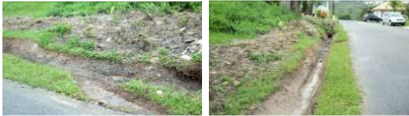
Abertura de valas na Av. das Américas
