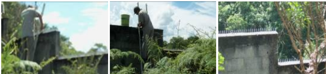
Colocação de lanças muro do condomínio Q 52
