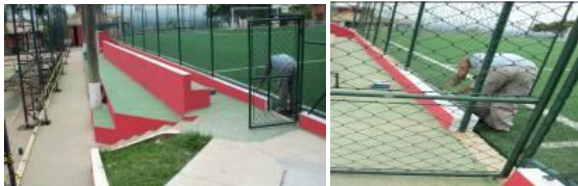
Continuação da pintura do clube
