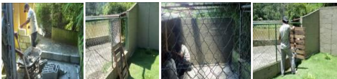
Reforma e manutenção do canil da chácara
