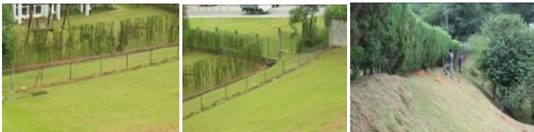
Colocação de alambrado para evitar entrada de animais
