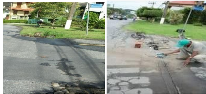
Corte e aprofundamento do canal de passagem de água
