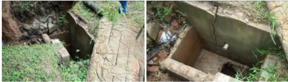
Caixa de águas pluviais Q19
